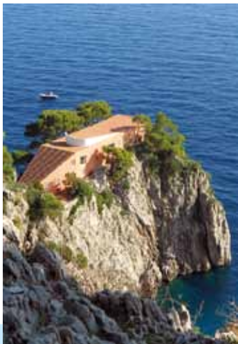
Casa Malaparte Malaparte's house
